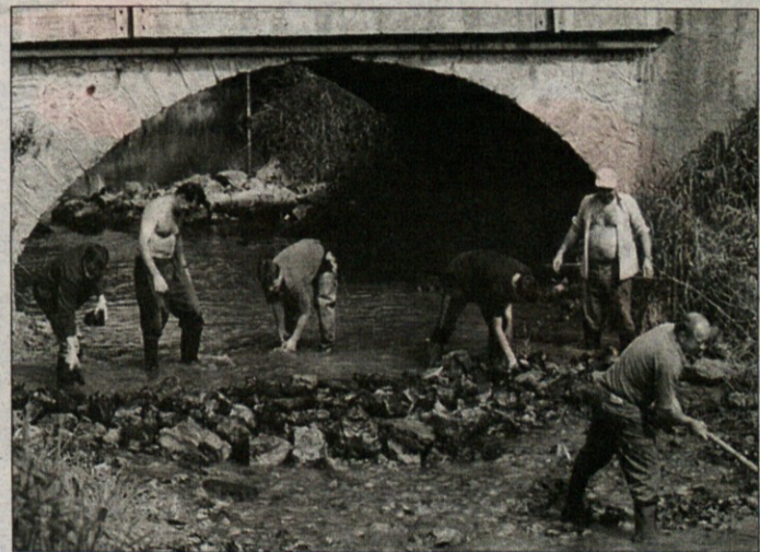
ZA ČISTO TEMENICO - Mirnopeski ribiči so pod vodstvom Petra Cesarja pod okriljem Ribiške družine Novo mesto, pododbor Trebnje, v nedeljo izvedli delovno akcijo čiščenja reke Temenice. S kamnom so zgradili tudi več prepračevalnih jezov, s katerimi so pripomogli k izboljšanju življenja rib in ostalega življa v Temenici. Ribiče tudi v prihodnje čaka veliko dela, saj je Temenica v Mirni Peči vsako leto bolj onesnažena, obstoječi jezovi pa so potrebni temeljitega popravila. Mirnopeski ribiči se zahvaljujejo lastnikom zemljišč za nemoten dostop do reke, podjetniku Zdravku Kukovcu za prevoz kamenja in vsem občanom za njihovo podporo, ribičem pa želijo dober prijem. (Foto: P. Cesar)
