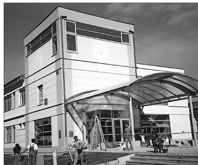
Dela na ormoški gimnaziji se bližajo koncu Foto: FI
