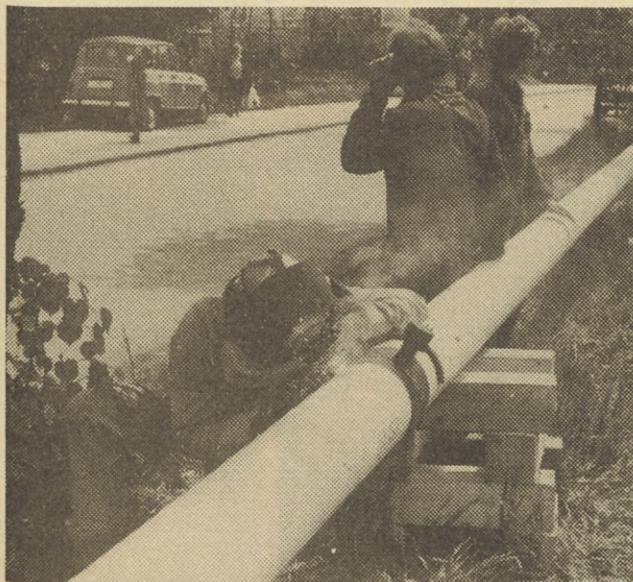
Prvi zvar na plinovodu
