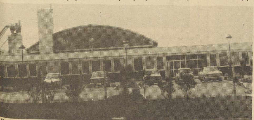
Pročelje novih prostorov v Izoli
