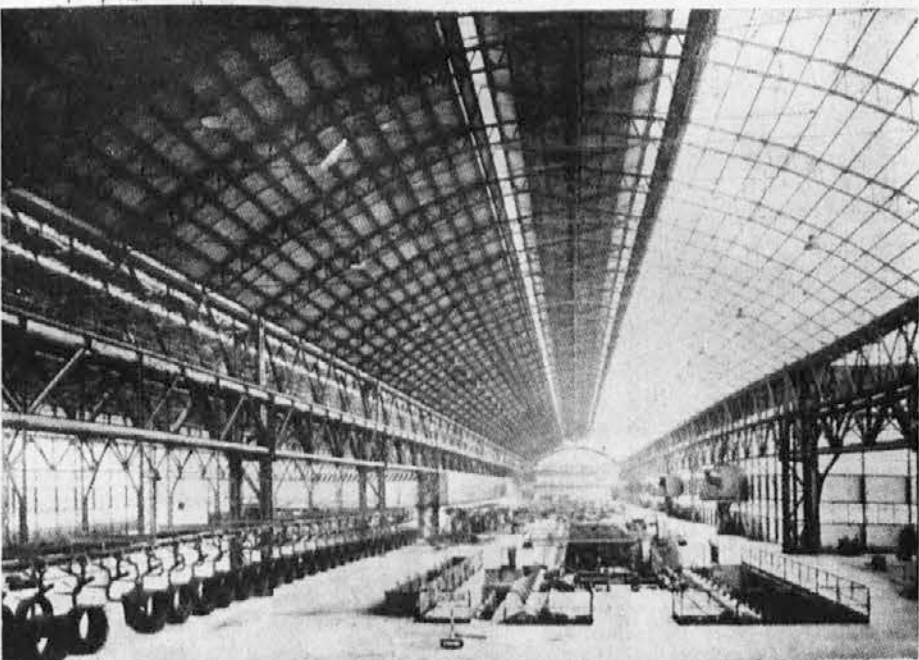
Pogled v notranjost nove valjarne «Cogne», ki je ena najmodernejših v Evropi. Načrt za ta obrat so napravili s sodelovanjem Svedov, stroji pa so bili — razen nekaterih elektronskih aparatov — izdelani v Italiji. Valjarna je popolnoma avtomatizirana in proizvaja nekatere žice široke potrošnje v hitrosti 22 metrov na minuto oziroma 79 km na uro.
