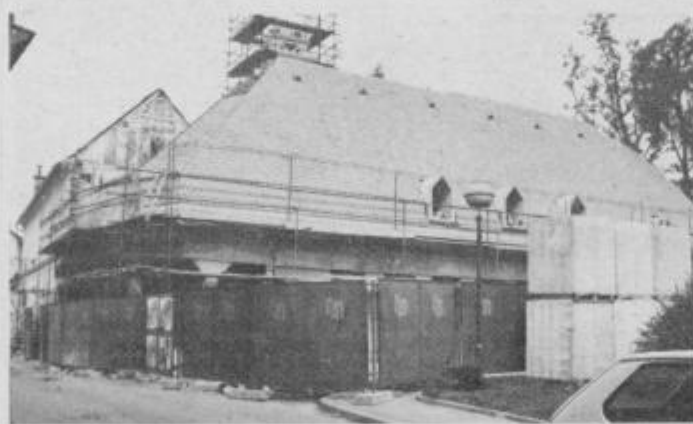
Pošto gradijo delavci gradbenega kombinata Medjimurje iz Čakovca. (Foto: Ema Zalar.) MG
