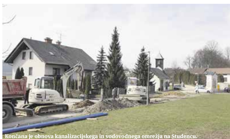
Končana je obnova kanalizacijskega in vodovodnega omrežja na Studencu.
