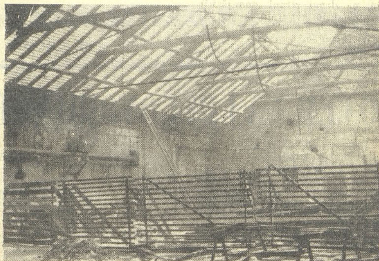
Rušenje stare steklarske hale. Na tem mestu bo stalo novo skladišče gotovih izdelkov
