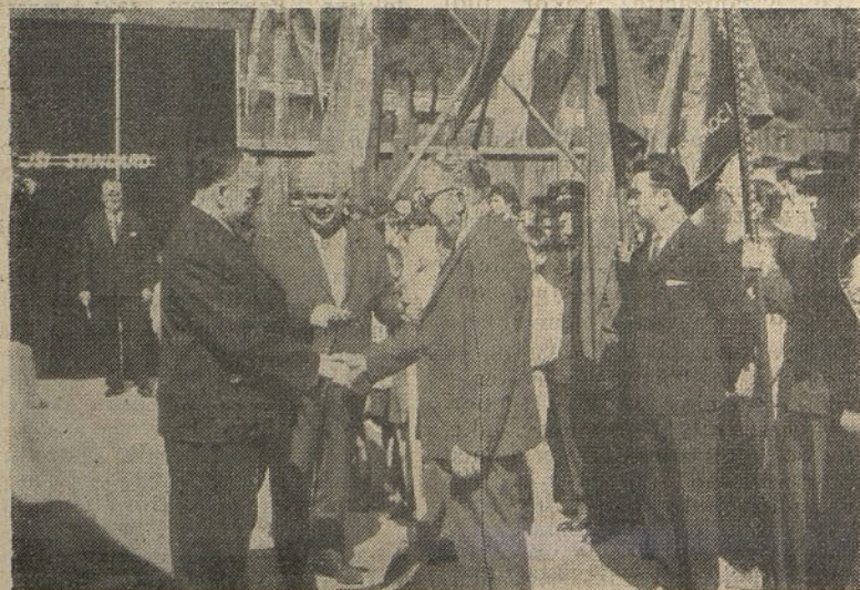
Tov. Miha Marinko je prisostvoval ob otvoritvi III. faze rekonstrukcije
