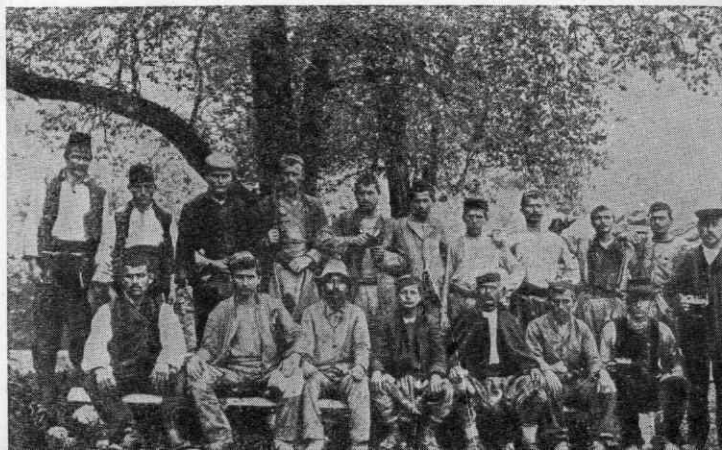
Sl. 2. Makedonski delavci pri gradnji železnice Celovec-Trst
