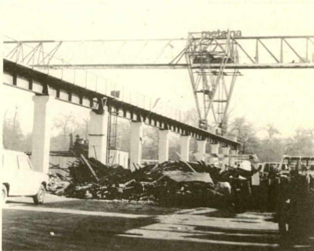
Dela na celjskem terminalu so v zaključni fazi
