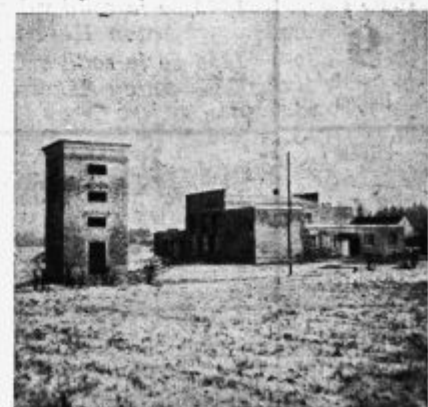
Slike predstavljajo novo relejno radijsko postajo na Teznem pri Mariboru.
