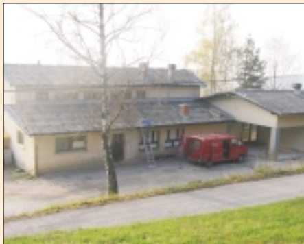
Streha ob začetku obnove
