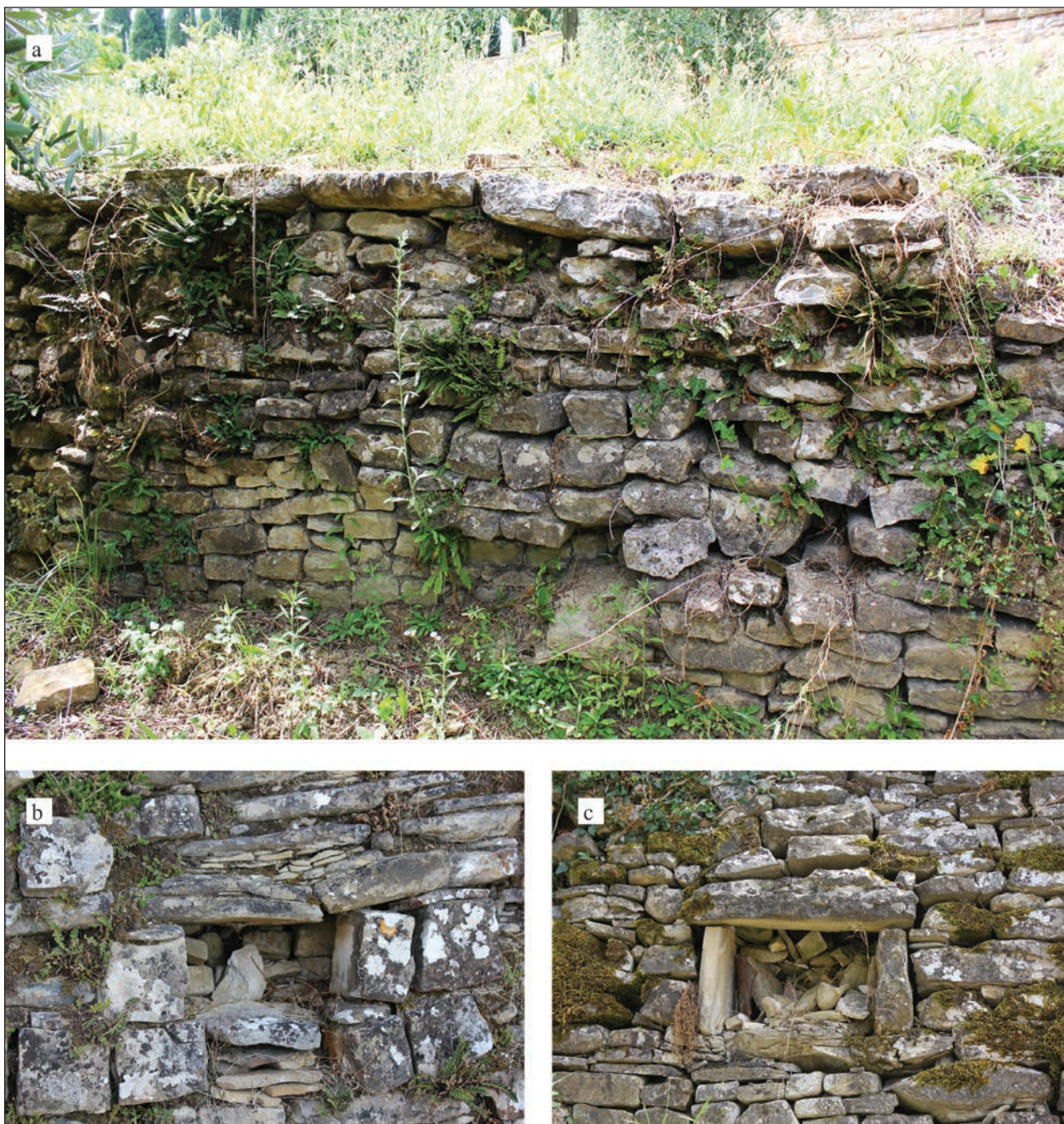
Slika 15: Posebnosti potpornih suhozida a) Završetak zida s većim i položenim komadima kamena, b) Niša u sjevernom dijelu obuhvata, c) Niša u zapadnom dijelu obuhvata.
