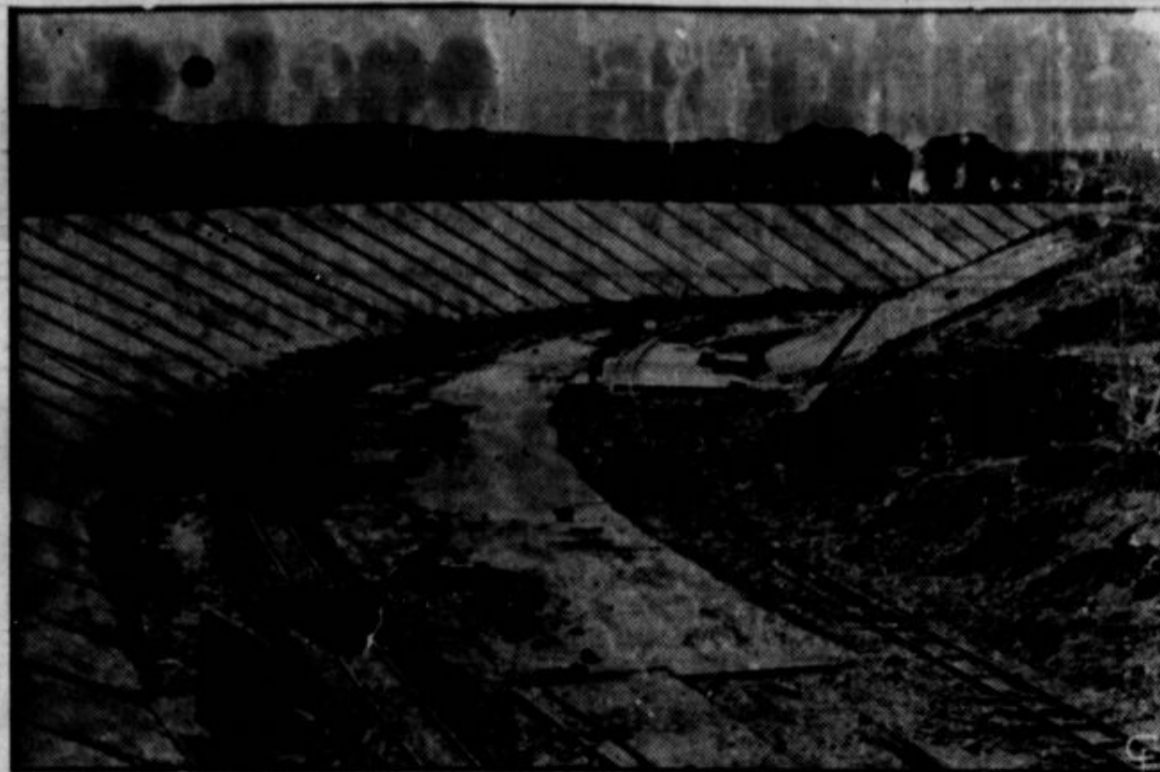
Tudi svetopisemska reka Jordan mora služiti moderni tehniki. Slika prikazuje umetno strugo reke Jordan, napeljana za elektrarno, ki bo oskrbovala z elektriko vso severno Palestino. Konstruktorska dela za spremenitev struge v prid elektrarne so bila v glavnem dovršena že koncem prejšnjega leta.
