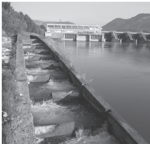
Slika 2: HE Vrhovo - prekatni del vhoda v drstišče Fig. 2: Vrhovo HPP - vertical-slot entrance to the spawning area
