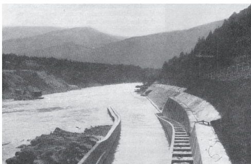
Slika 6: Izliv ribjega prehoda v reko Dravo (Munda, 1928)
