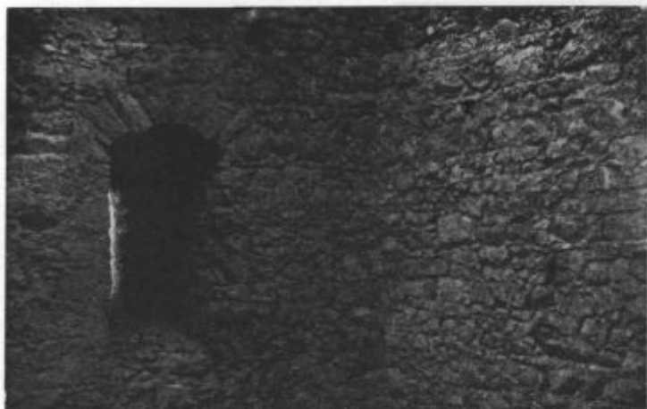
Zidna konstrukcija bergfrida
