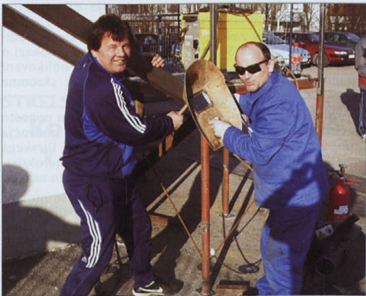
Izdelava stopnic na teraso objekta
