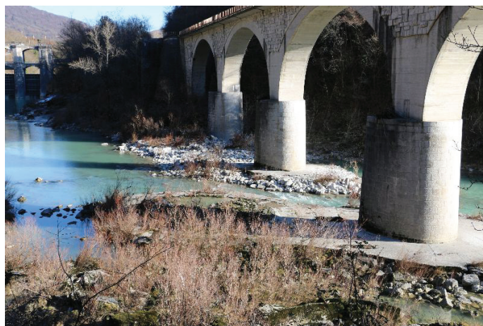
Slika 16. Še danes sta v strugi Soče lepo vidna ostanka betonskih stebrov starega kamnitega mostu iz leta 1906. Viden je še vedno tudi kamniti obroč okoli betonskega jedra obeh stebrov. Foto: Gorazd Humar, jan. 2022 [Humar, 2022].
