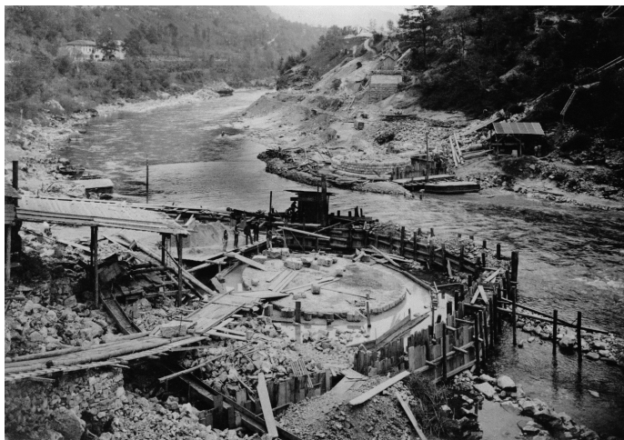
Slika 3. Izdelava temeljev obeh stebrov v strugi Soče poleti leta 1904. Temelji so bili izdelani iz betona. Foto: arhiv Tolminkskega muzeja [Tolminski muzej, 2020].
