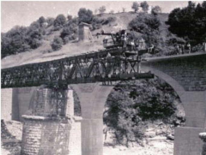
Slika 13. Ob dokončanju novega armiranobetonskega ločnega mostu v Ajbi novembra 1954 so pričeli postopno odstranjevati vojaški jekleni provizorij Roth-Waagner, ki ga je leta 1945 postavila zavezniška vojaška uprava. Foto: osebni arhiv Gorazda Humarja [Humar, 2022].
