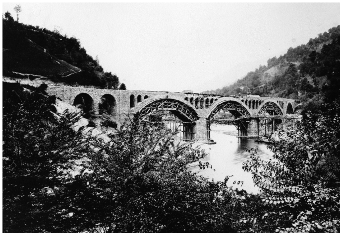
Slika 5. Zaključna faza gradnje mostu jeseni leta 1905. Foto: arhiv Tolminskega muzeja [Tolminski muzej, 2020].
