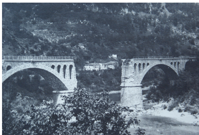
Slika 7. V tretji soški bitki oktobra 1915 so minerci avstro-ogrske vojske ob umiku razstrelili srednji lok iz skupine treh 40-metrskih lokov. Foto: arhiv Tolminskega muzeja [Tolminski muzej, 2020].
