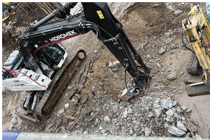
Slika 8. Pikiranje podpornega zidu med cestiščem in hodnikom za kolesarje in pešce.
