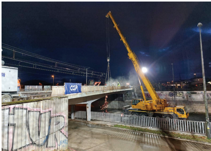
Slika 3. Pogled na pritrditev prednapete AB-plošče na avtodvigalo.
