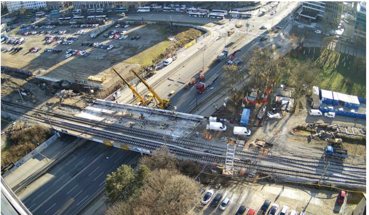
Slika 1. Pogled na gradbišče v času izvedbe rušitvenih del na južnem delu nadvoza čez Dunajsko cesto v Ljubljani.
