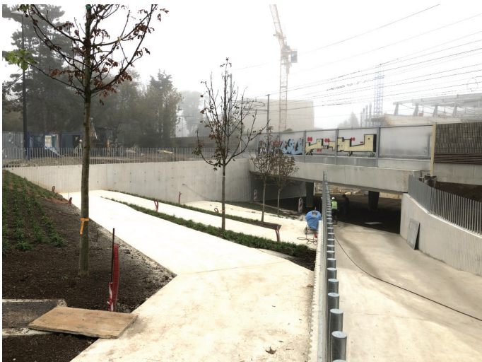
Slika 13. Gradnja izhoda iz podhoda.
