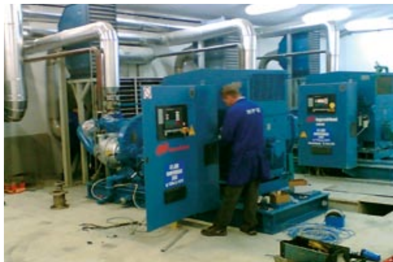
Montaža kompresorja za PD1
