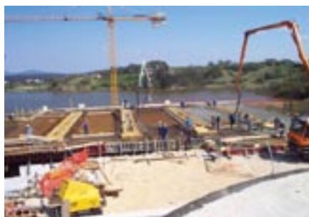
Začetek vlivanja armirane betonske plošče
