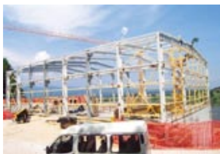
Izgradnja jeklene konstrukcije zgornjega dela
