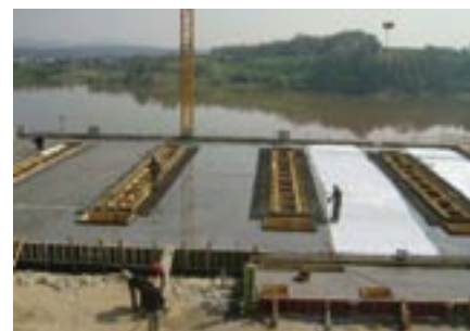
Zaključevanja vlivanja armirane betonske plošče.
