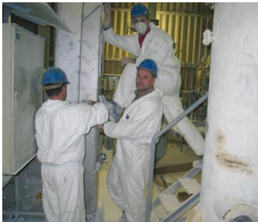
Remont Z elevatorjev
