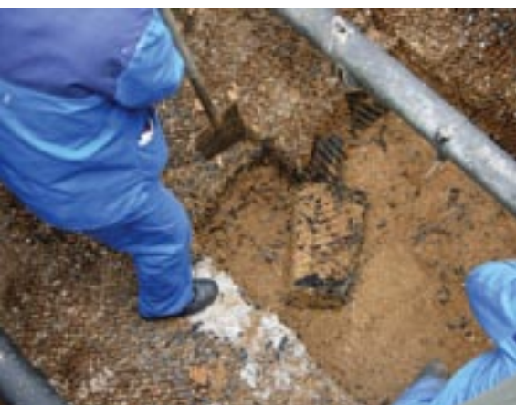
Odstranjevanje polnil v hladilnem stolpu
