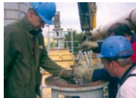
Menjava ležajev mešala v nevtralizaciji
