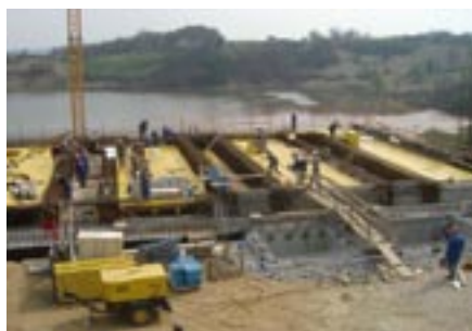
Priprava železne armature ter opaža
