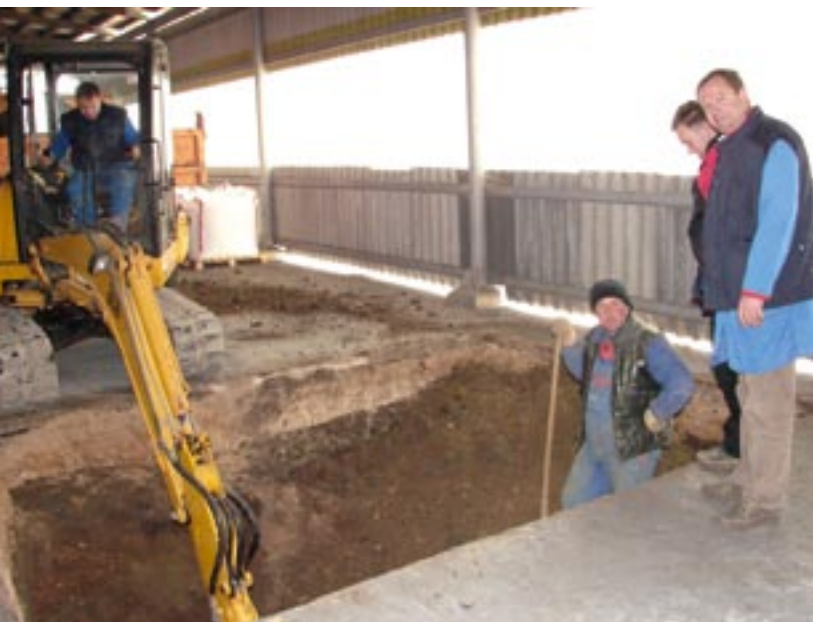
Zamenjava pitnega vodovoda v skladišču PE TiO 2
