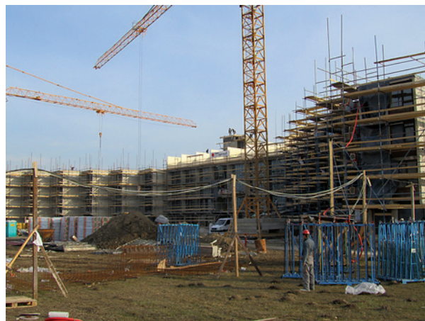
Montaža lesenega dela (foto: B. Dujič)
