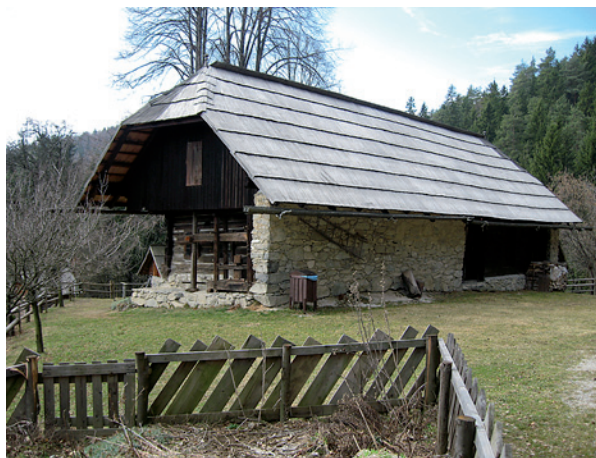
Slika 2. Severna stran osrednjega poslopja Kavčnikove domačije, ki so ji že v 19. stoletju iz povsem varnostnih namenov pozidali kamnit oporni zid (foto: V. Hazler, 3.3. 2008).
