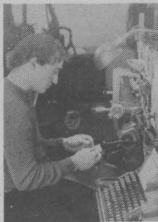
Le še redke tiskarske hiše imajo stroje za vlivanje svinčenih črk. V Učnih delavnicah pa kadre usposablja tudi na teh strojih in seveda na najmodernejših ofsetnih.
