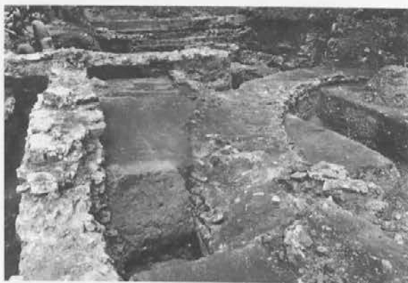
Sl. 6: Ljubljana, Ferantov vrt. Pogled na zahodni del zidu rotunde.
