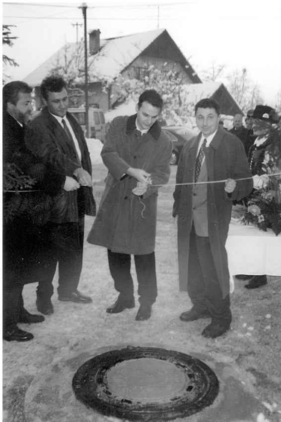
Odprtje kanalizacije v Podgorju. Foto: F. Svetelj.
