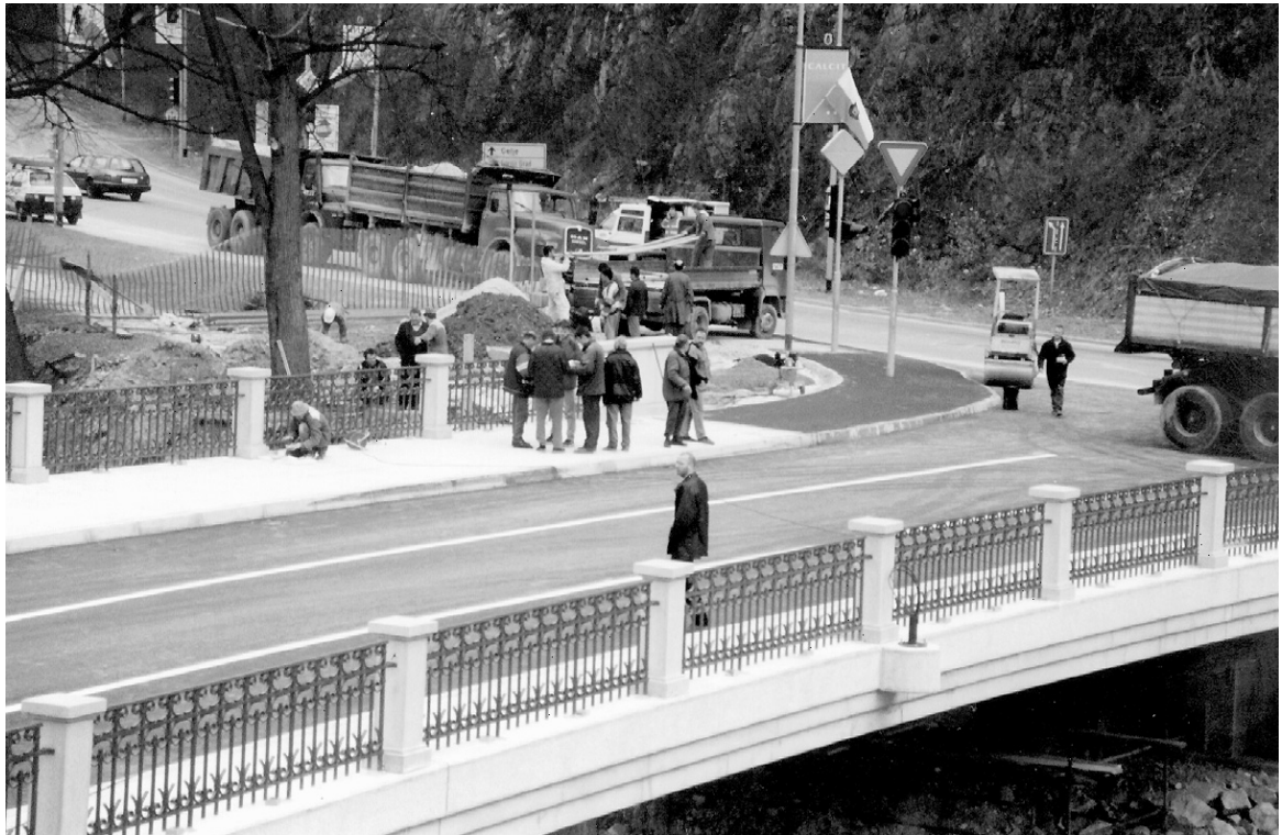
Maistrov most med gradnjo. Foto: F. Svetelj.
