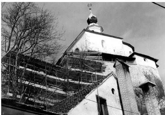
Obnova malograjskega obzidja in kapele – januar 2000. Foto: F. Svetelj.
