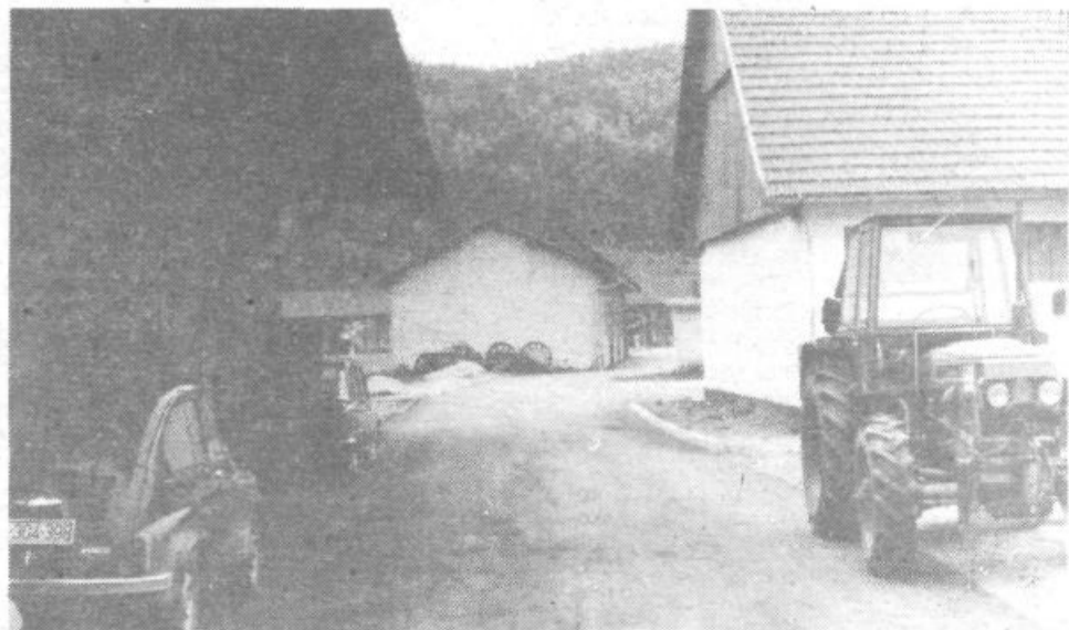
Na posestvu Brest so asfaltirali okrog 1500 kvadratnih metrov voznih in delovnih površin
