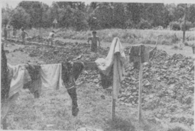
Brigadirji pri izkopu jarka ... Foto: M. Ozmeč
