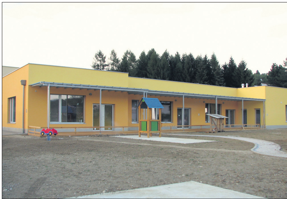
Izgradnja vrtca v Podlehniku je v zaključni fazi; čeprav navzven ni videti, je vrteški objekt po svoji zasnovi in prostornosti luksuzen.
