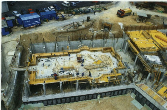
Slika 3 • Plošča prve polovice termalnega bazena
