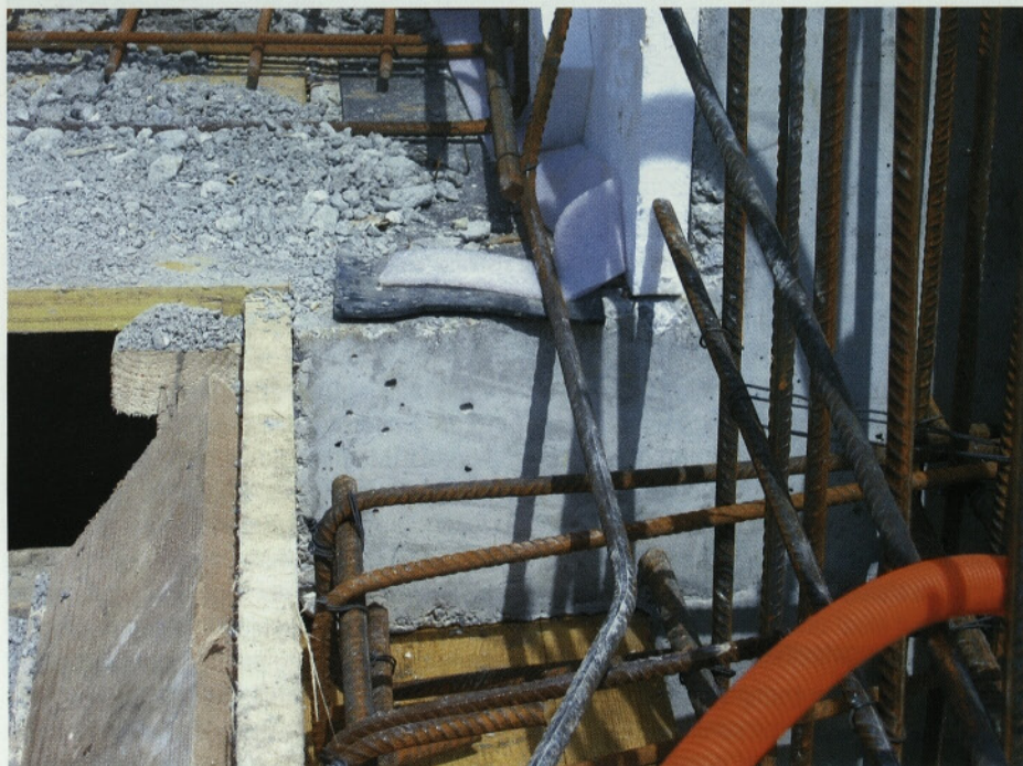
Slika 2 • Neoprensko ležišče na konzolnem ležišču AB konstrukcije bazena
