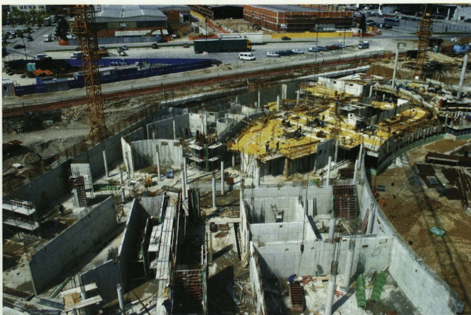
Slika 1 • Posebnost vodnega mesta Atlantis je velika razgibanost betonske konstrukcije
