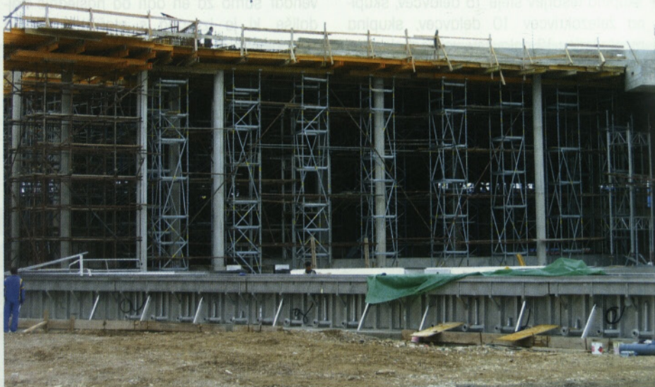
Slika 10 • Podporni sistem in opaž strešne plošče nad bazeni
