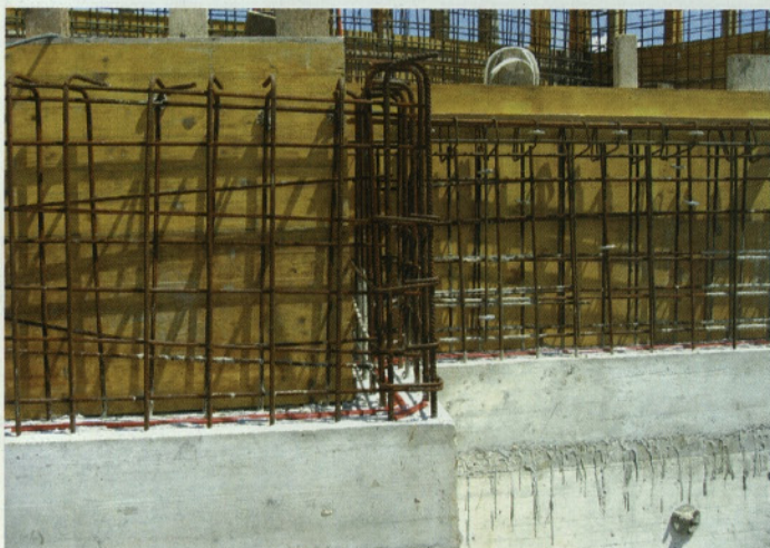
Slika 6 • Nabrekajoč tesnilni trak na stiku plošče s steno bazena
