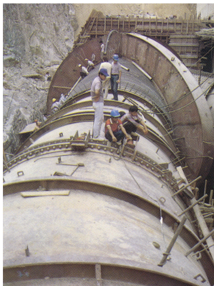
Slika 1 • Gradnja tlačnega cevododa Chiew Larn, Tajska
