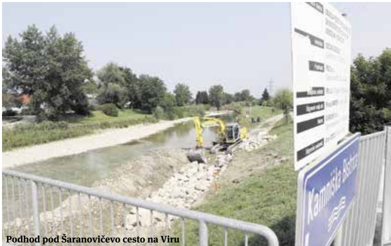
Podhod pod Šaranovičevo cesto na Viru
