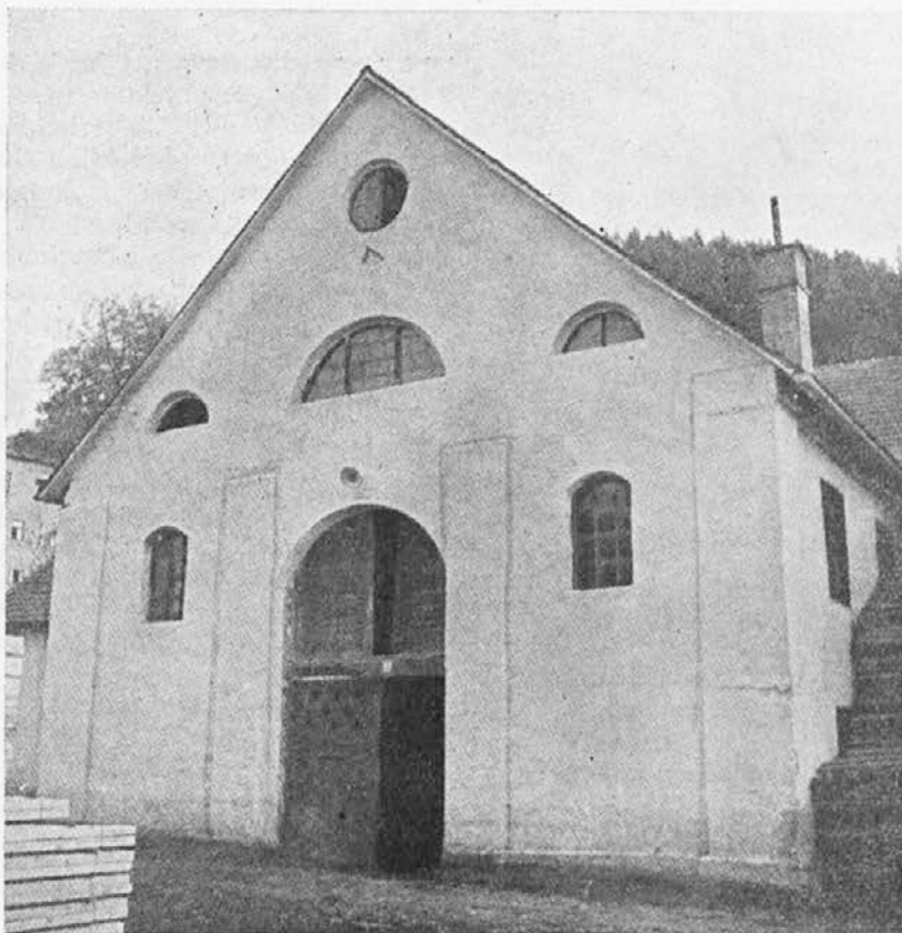
Nekdanja spodnja fužina, sedaj sodarna
