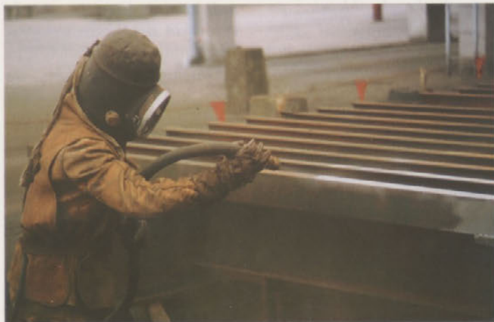
Zahtevno in težko delo peskanja tehtnice
