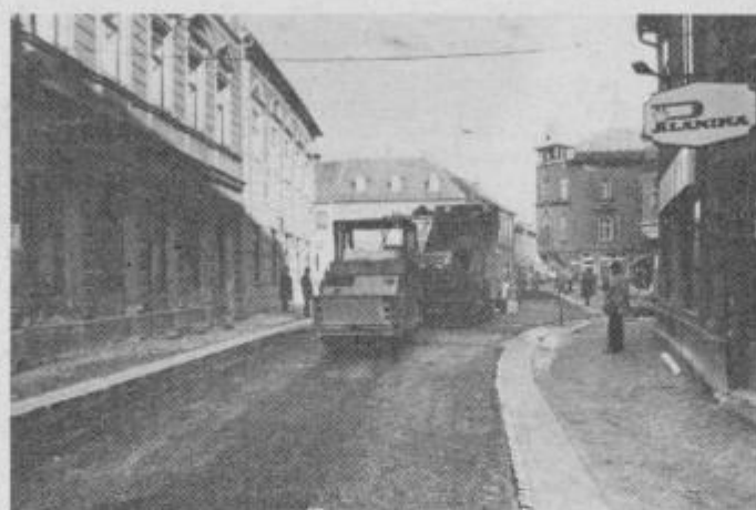
Takšna je bila videti Krempljeva ulica v torek, 24. novembra dopoldne, s Trga svobode, ko so polagali prvo grobo asfaltno prevleko.
