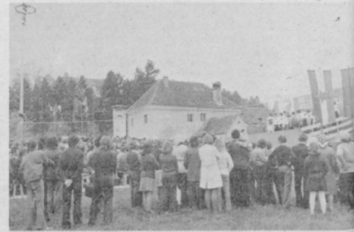
Položitev temeljnega kamna so povezali s proslavo letošnjih jubilejev.
