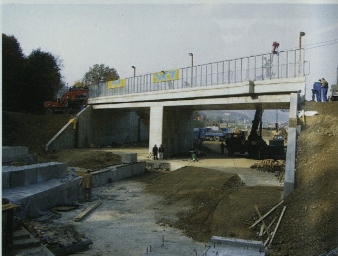
Slika 12 • Končni položaj objekta po končanem potiskanju
