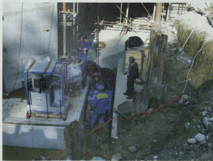
Slika 7 • Montaža hidravličnih naprav
