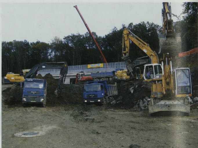
Slika 10 • Izvedba izkopa železniškega nasipa
