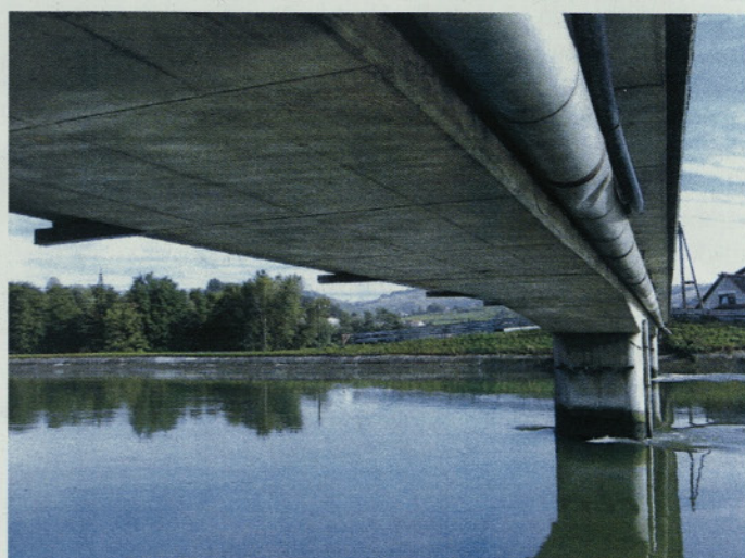
Slika 4 • Pogled na brv od spodaj pred rekonstrukcijo
