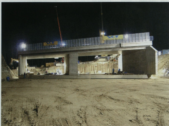
Slika 11 • Potiskanje je potekalo neprekinjeno tudi preko noči
