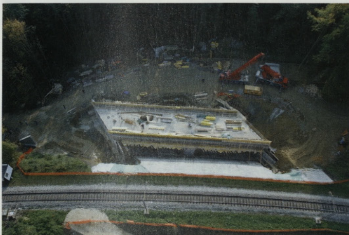
Slika 5 • Izdelan objekt zunaj železniškega nasipa
