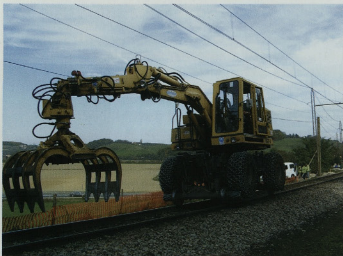
Slika 9 • Pripravljalna dela na tiru ob zapori železniškega prometa
