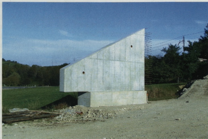
Slika 6 • Montažni del krilnega zidu
