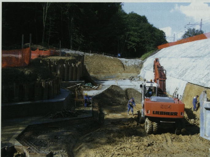
Slika 3 • Izkop gradbene jame in priprava delovnega platoja
