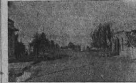
Netlakovana cesta Tinogasta, kjer je hudo, ko dežuje, a voda kmalu odteče, ker ima zemlja visoko lego. V kratkem bo občina začela s tlakovanjem.
