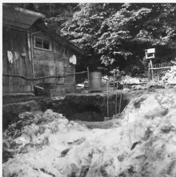
Sl. 1: Izkop za novo hišo. Levo je stara hiša. Vidi se ilovnati profil oglja, kjer so bile prve najdbe.
