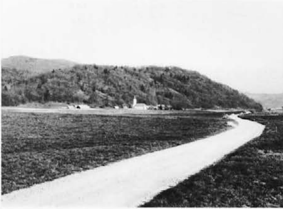
Sl. 41: Mali vrh nad Srednjim Globodolom. Pogled na naselje z jugovzhoda.
