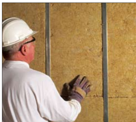
Izolacijski izdelki iz mineralne volne podjetja Thermafiber: Thermafiber proizvaja vrsto izolativnih sistemov iz mineralnih vlaken, katerih surovina je reciklinarna žilindra železove rude. Uporabljajo se za toplotno, zvočno in ognjevarno izolacijo stanovanjskih ali poslovnih objektov.
