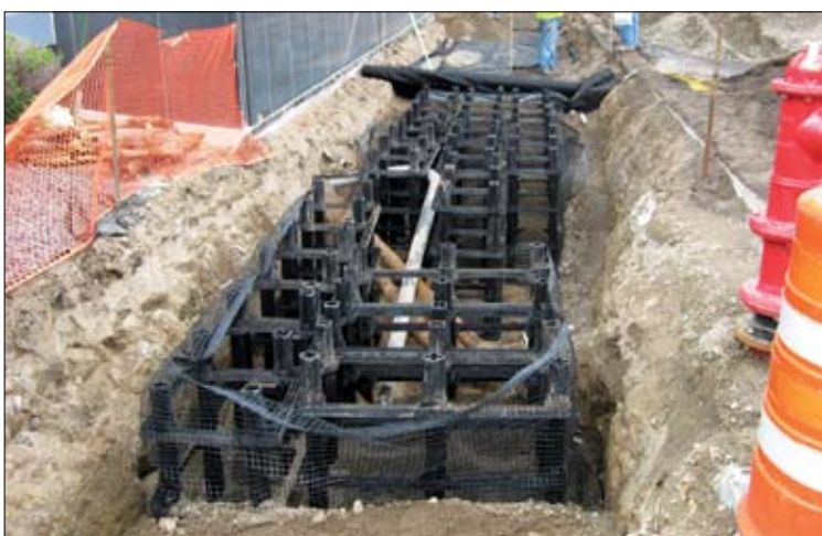
Silva Cell, podzemna drevesna zaščita in sistem za shranjevanje vode: Silva Cell je modularni sistem, ki zadržuje prst in vlago, potrebno za rast dreves in je hkrati temelj za tlakovane površine. Drevesa v urbanem okolju znižujejo učinek lokalnega pregrevanja, čistijo zrak in zadržujejo padavine. Poleg tega proizvajajo kisik in nas povezujejo z naravnim okoljem.
