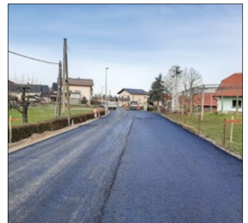
Urejanje lokalne ceste v Gerečji vasi
