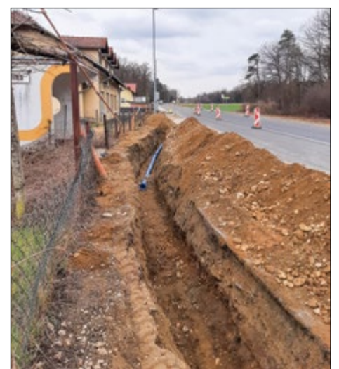
V naselju Zg. Hajdina potekajo obnovitvena dela na vodovodnem sistemu.
