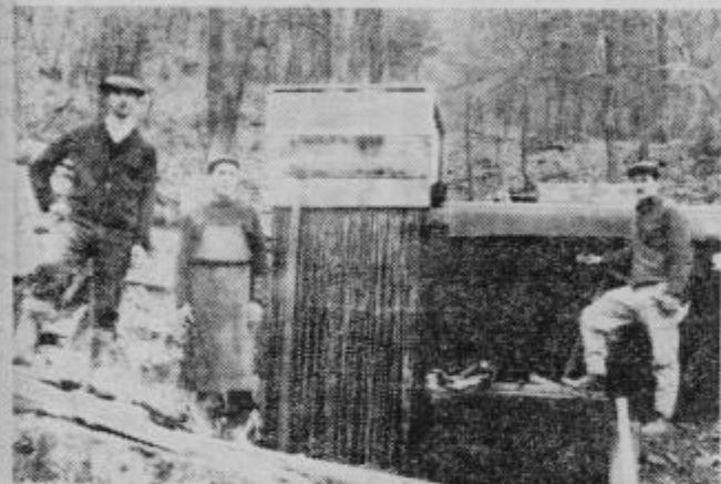
Zadnja dela pri gradnji vodovodnega rezervoarja pod Resnikom
