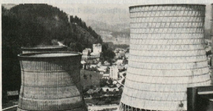
Levo, hladilna stolpa TEŠ I in II, zgrajena s pomičnimi odri - desno, hladilni stolp TEŠ III, postavljen z montažno izgradnjo
