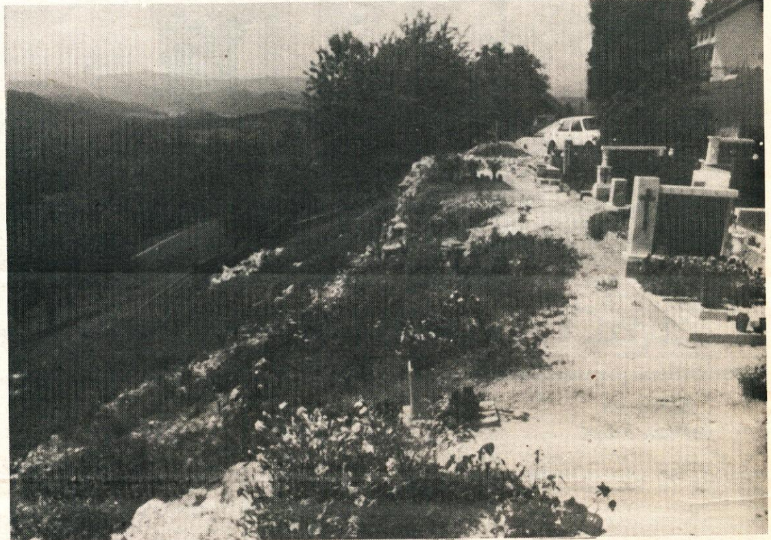
Porušen oporni zid na pokopališču na Libergi. (Foto: GO)
