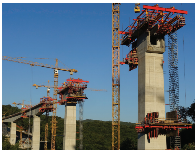
Slika 12. Trije pari konzolnih vozičkov istočasno v uporabi, september 2023.
