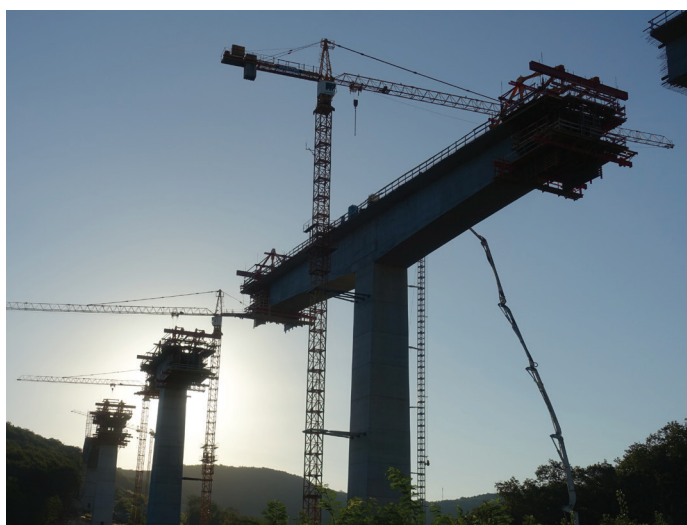
Slika 11. Vgradnja betona mora potekati simetrično na obe strani konzolne mize, september 2023.
