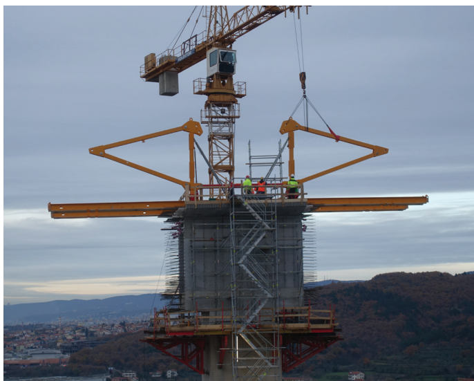
Slika 7. Montaža nosilnih konzol vozička v osi 7, december 2022.
