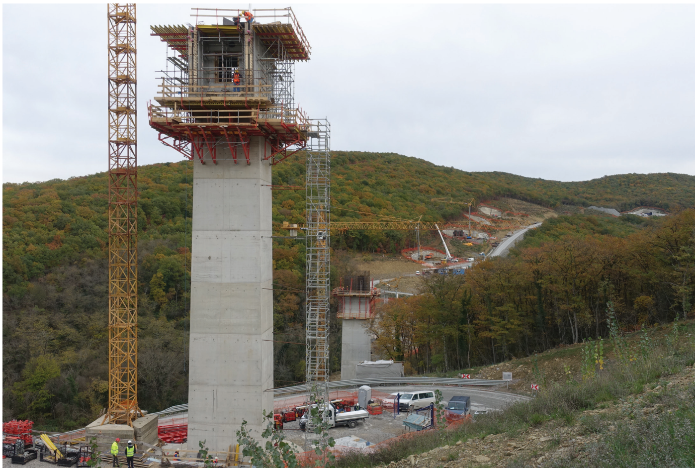
Slika 6. Izdelava baznega segmenta v osi 7, november 2022.
