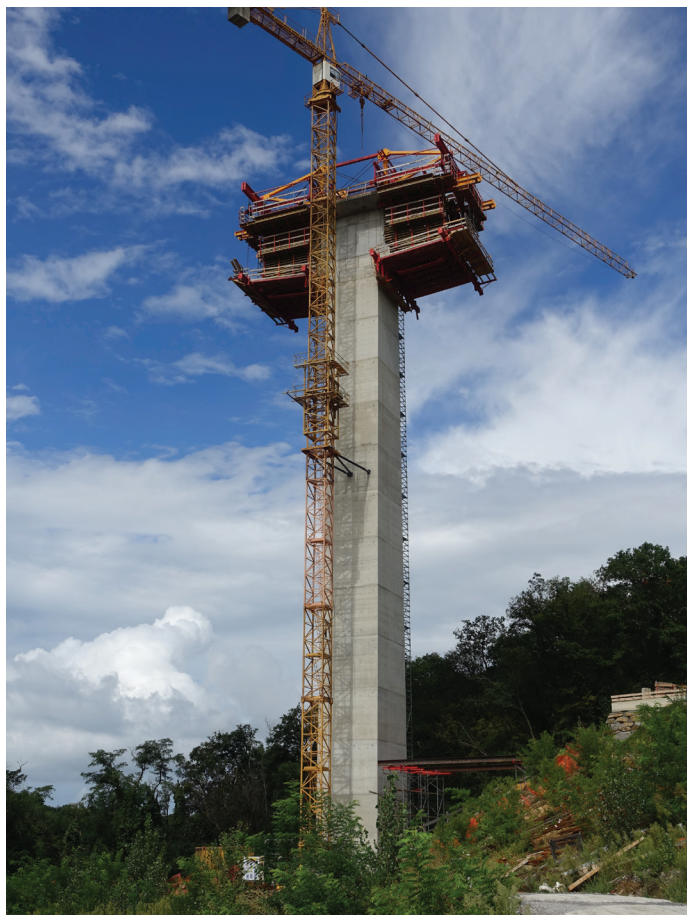
Slika 9. Dokončana montaža opreme PKG v osi 5, avgust 2023.
