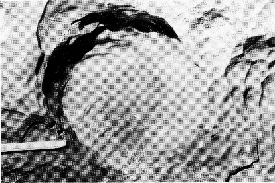
Sl.7 Erozijska kotlica v koritu vodnega rova (merilo je 0,15 metra)
