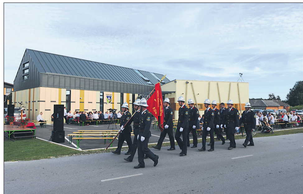
Nov večnamenski center v Sobotincih je moderen, nizkoenergetski objekt, ki bo služil vsem vaščanom in društvom na vasi.
