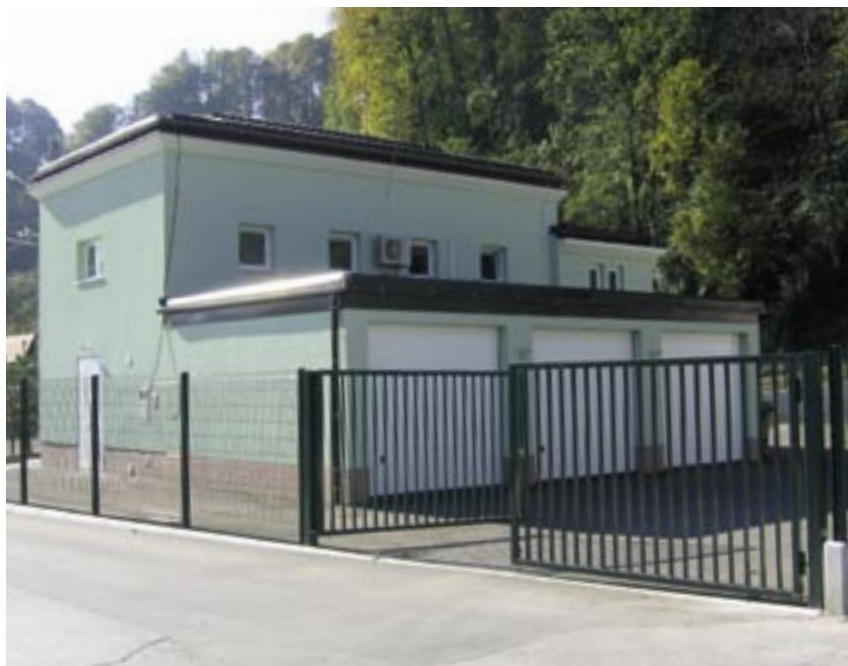
RP 20 kV Laško mesto po končani rekonstrukciji.
