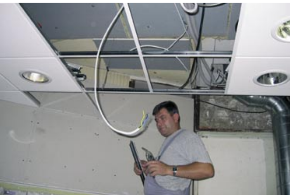
Montaža novega stropa v komandni sobi.
