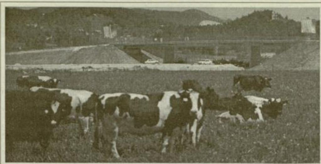
Nadvoz nad avtocesto Podlog-Pekel je dolg približno 400 metrov in leži v bližini farme Podlog.
