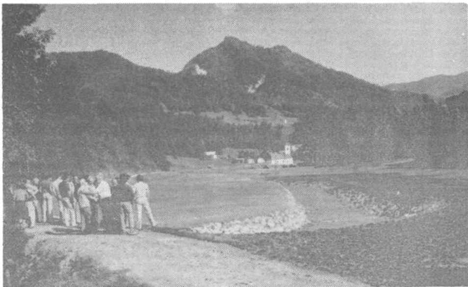
»Amočvirjena, neuporabna zemljišča ob Mali vodi so zamenjali po ureditvi struge pri Brišah kakovostni travniki.
