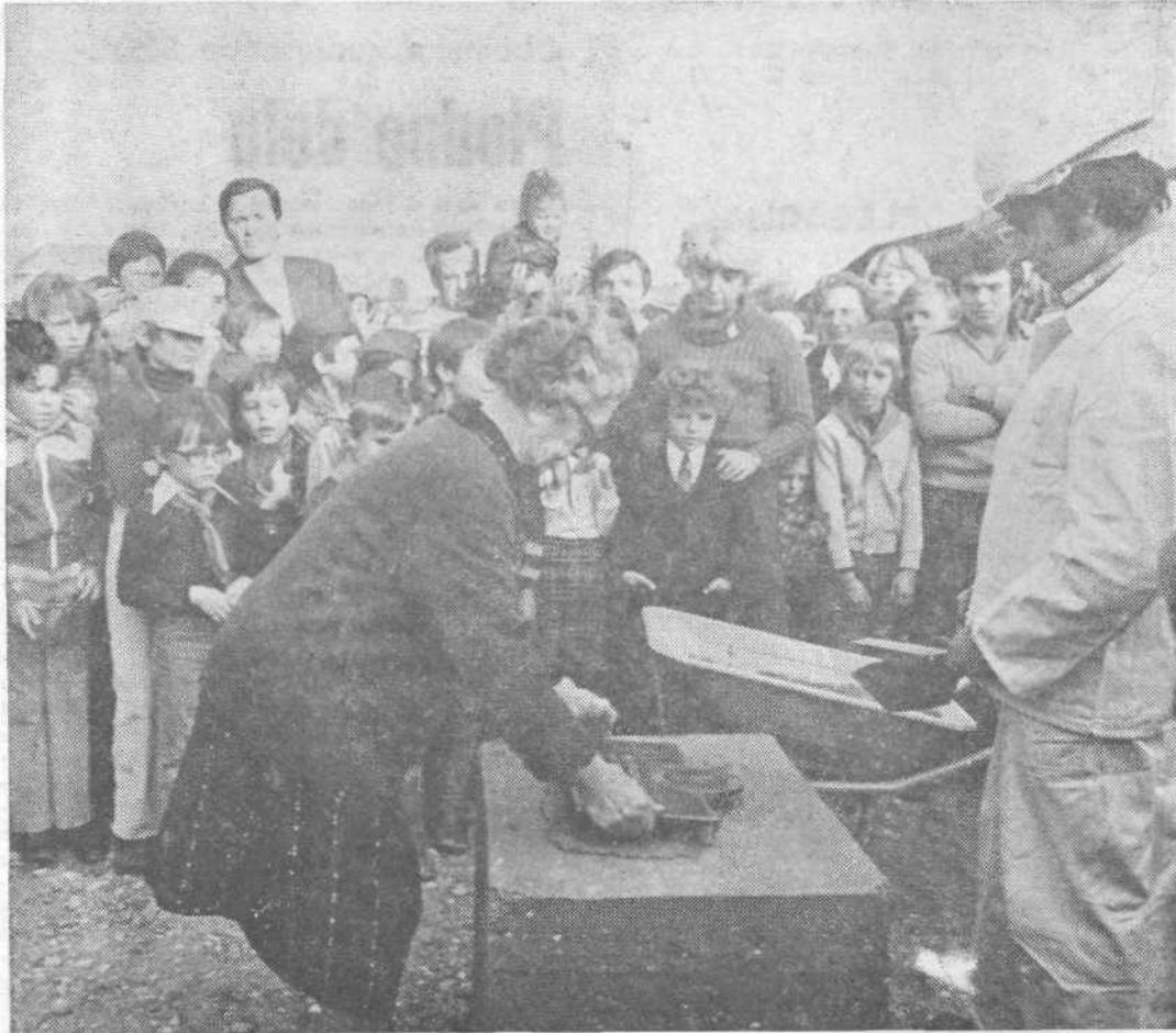
29. septembra je kmetovalka Marija Avšič položila temeljni kamen za vzgojno-varstveni zavod v Kosezah, ki bo 12. objekt iz sredstev samoprispevka I v naši občini. Objekt, ki bo veljal 13 milijonov dinarjev, bodo zgradili delavci celjskega Ingrada. V njem bo prostora za 160 predšolskih otrok, ki se bodo vanj vselili že v prihodnjem letu.
