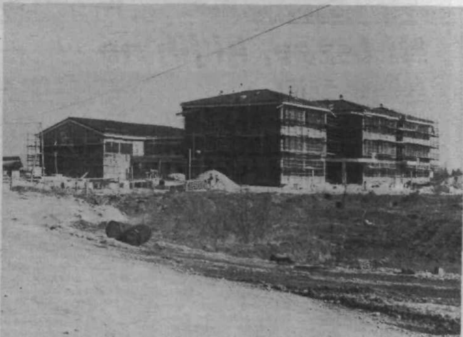
ŠE ENA ŠOLA IZ SAMOPRISPEVKA - Vzgojni zavod Janeza Levca se bo jeseni preselil v nove prostore za Bežigradom. Predvidevajo, da bo gradnja končana že junija, v začetku julija pa bo tehnični prevzem. V napovedih se verjetno niso zmotili, kar dokazuje tudi zunanji videz zgradbe.
