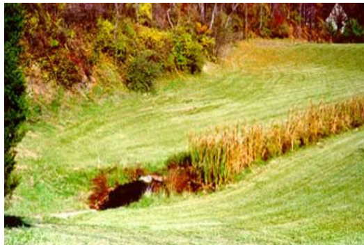
Slika 32: Zadrževalnik z mokriščem v najnižji točki obdelovalne površine.
